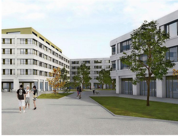
60 logements verront le jour à Chavannes-près-Renens. BCO
