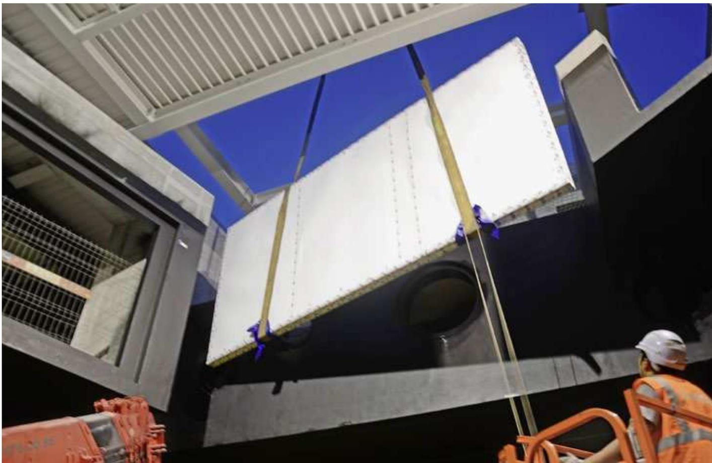
L'étape la plus délicate du chantier a été la pose des acryliques, de 18 cm d'épaisseur, des deux plus grands aquariums du complexe. Deux grues, l'une à l'extérieur et la seconde à l'intérieur, ont été nécessaires pour installer ces pièces via une ouverture dans le toit.
