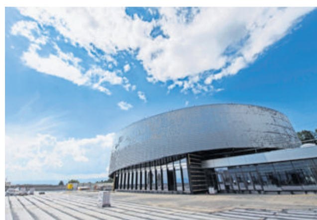
Sur la façade, 100 000 disques en aluminium bougent au gré du vent, clin d'œil aux écailles des poissons.
