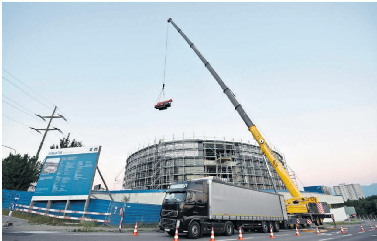
Une grosse grue était à l'œuvre dans la soirée d'hier sur le site du chantier d'Aquatis. Des plaques d'acrylique servant à la construction des aquariums devaient être placées dans la nuit dans les infrastructures en béton. PATRICK MARTIN
