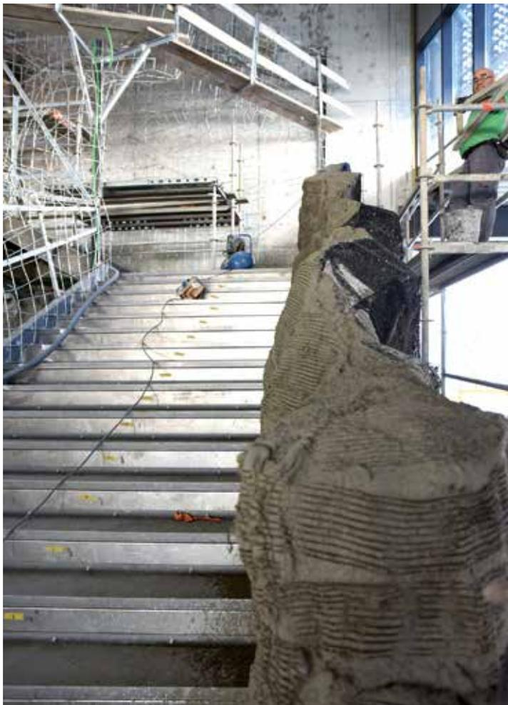
Pour les décors, une maille métallique sert de support (à gauche sur la photo ci-dessus) à une toile sur laquelle deux couches de béton spécial sont posées.
